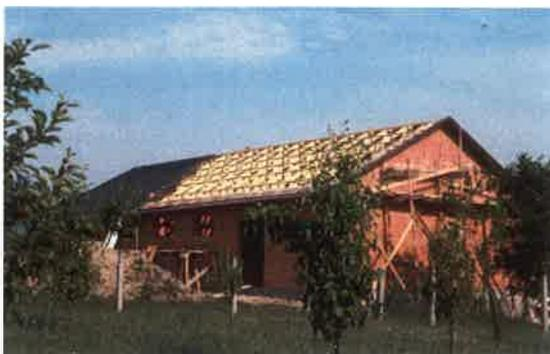
schließlich das Dach mit Eternit-Platten gedeckt (siehe Abbildung), so dass nun
